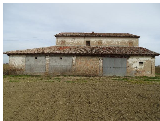
103 e 104 – Case coloniche dell'area centuriata (via Boscabella e via Capannaguzzo). Il portico è parzialmente tamponato per ricavare servizi e le finestre del piano primo sono "tagliate" dalla falda di copertura del portico per permetterne l'introspezione.
