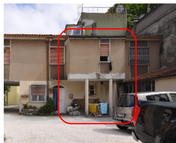
63 e 64 – Esempi di corpo edilizio aggiunto e di corpo estraneo all'organismo edilizio.
