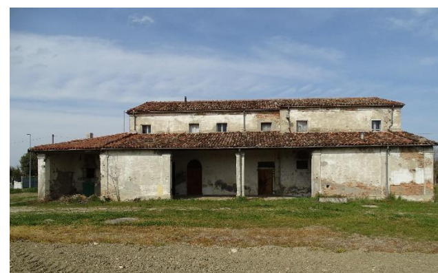
105 e 106 – Case coloniche dell'area centuriata (via Torri e via Stradone Sala). Le dimensioni longitudinali della casa sono determinate dai diversi tipi di stalla e/o da organici incrementi laterali di cellule a servizio (piano terra) e abitative (piano primo).
