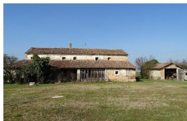
105 e 106 – Case coloniche dell'area centuriata (via Torri e via Stradone Sala). Le dimensioni longitudinali della casa sono determinate dai diversi tipi di stalla e/o da organici incrementi laterali di cellule a servizio (piano terra) e abitative (piano primo).
