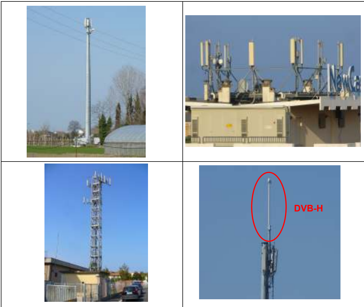
Figura 2: Esempi di SRB e DVB-H installati nel Comune di Cesenatico
