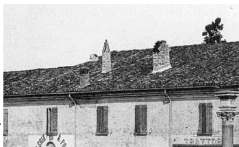
Esempi di camini tradizionali lungo il porto canale.
