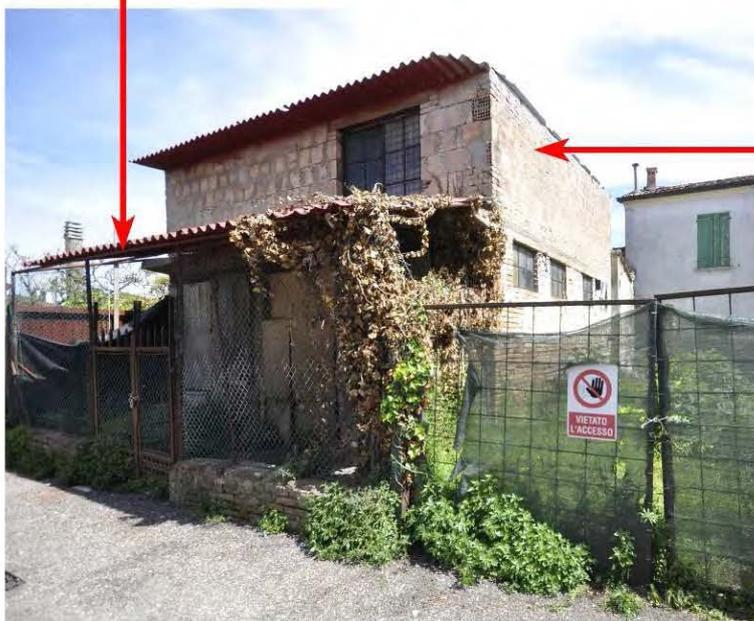
Piano primo del corpo edilizio da demolire e realizzazione di un tetto a due falde con pendenza tradizionale (30%) e copertura in coppi.
