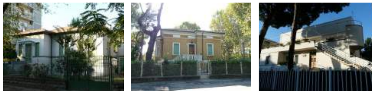
92, 93 – Villini primi '900 ad un piano fuori terra, 94 Villa razionalista (Villa Placucci, arch. Saul Bravetti 1937)
