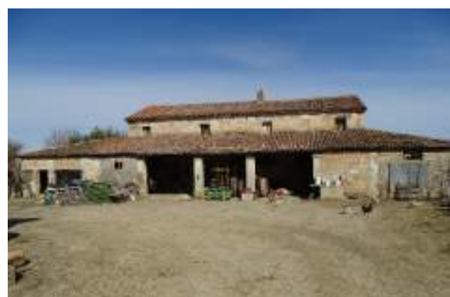
103 e 104 – Case coloniche dell'area centuriata (via Boscabella e via Capannaguzzo). Il portico è parzialmente tamponato per ricavare servizi e le finestre del piano primo sono "tagliate" dalla falda di copertura del portico per permetterne l'introspezione.
